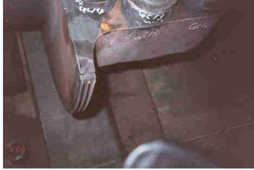
图 4 高压内缸夹层下半-持环加退让式汽封
